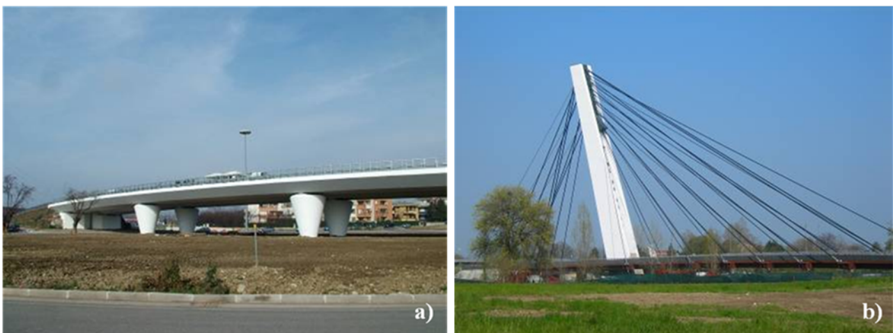
Figura 3: a) Parma - viadotto autostradale trattata con pittura bianco riflettente; b) Parma – antenna del ponte “De Gasperi” trattata con pittura bianco riflettente.
